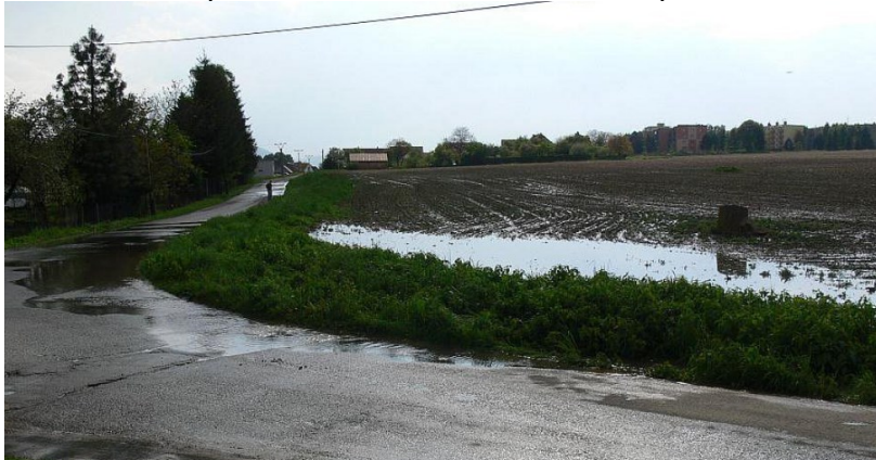
Obr. 3 Silnice poškozené mimořádnou událostí pouze minimálně
